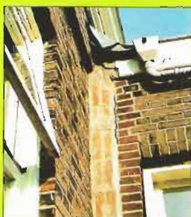
Onderheide schuurtjes en tuinmuren zijn op hun plaats gebleven. Op foto twee 2 is een tapscheurvorm te zien. Een gevolg van de kanteling.
