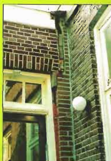
Onderheide schuurtjes en tuinmuren zijn op hun plaats gebleven. Op foto twee 2 is een tapscheurvorm te zien. Een gevolg van de kanteling.
